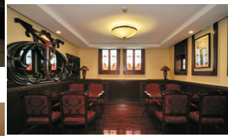
地下1階の照明 シャンデリアのランプにLED電球を、外周部の平天井部には高演色LEDダウンライトを採用
