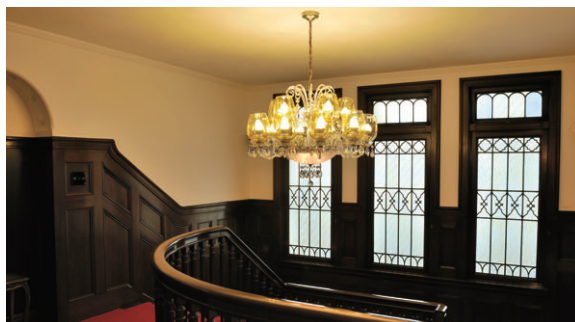
階段吹抜けに設置されたシャンデリア ランプをLED電球に更新し、高い輝度によりきらめき感を向上
