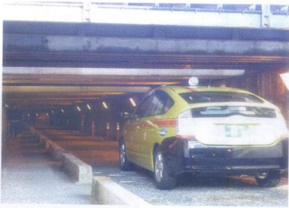
高輪橋架道橋を通過するタクシー。車種はさほど車高が高くないプリウスだが、それでも天井ギリギリ
